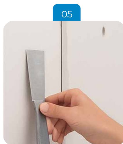
Rellena tornillera y aplique la tercera mano del producto
